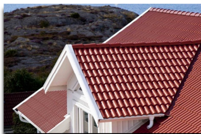
Benders Palema Candor , tvåkupig betongpanna med blank ytbehandling.
